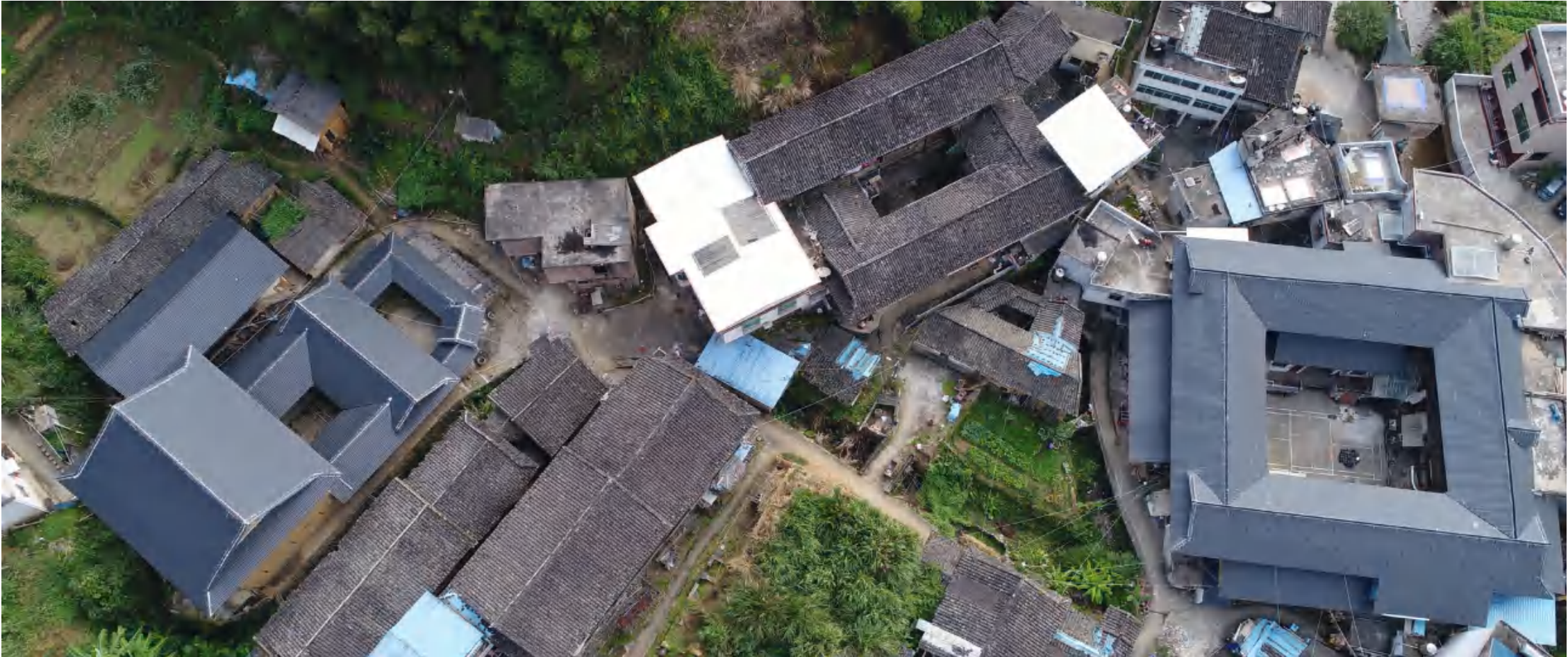
修缮后的永定区龙潭镇虞溪村土楼
